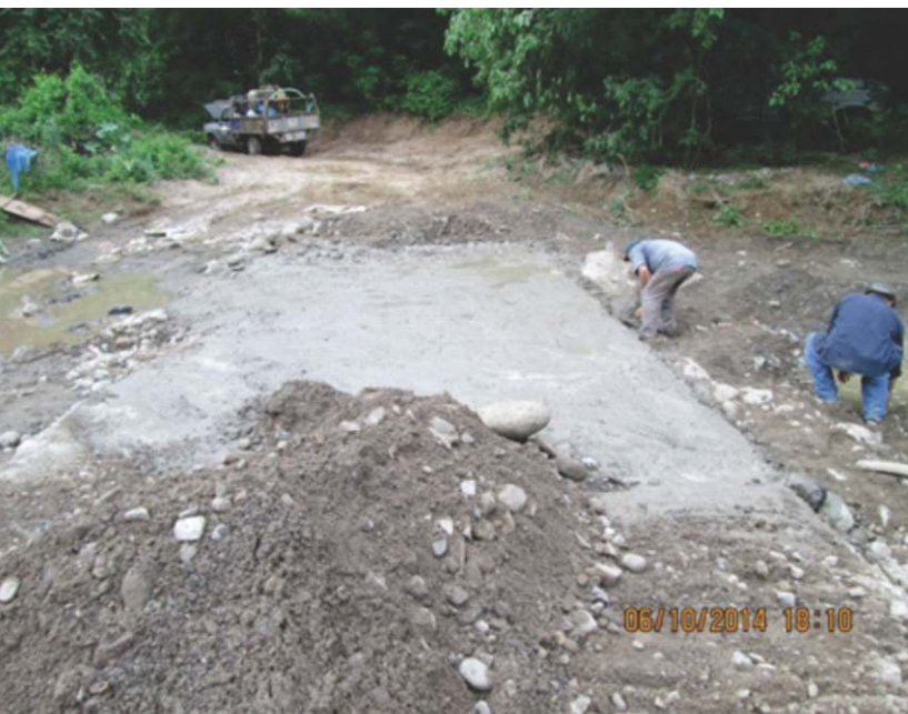
Construcción de vado vehicular camino la Cahuinga-Gallardo-Tandinguán $ 15,200.00
