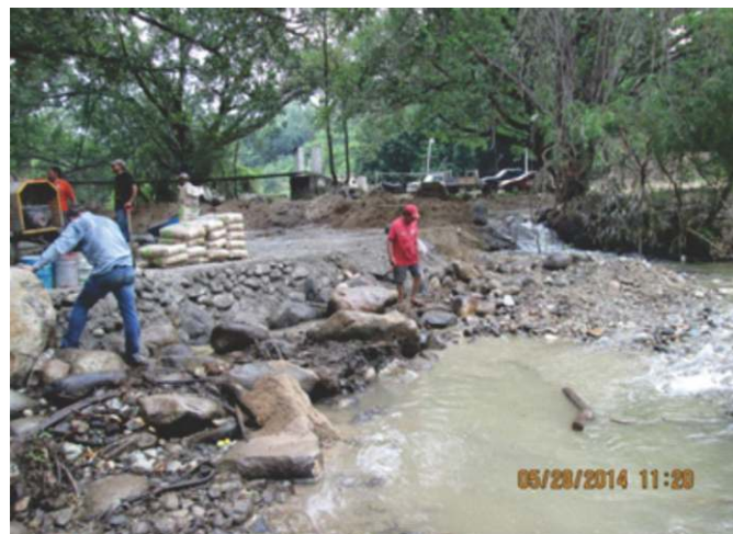
Rehabilitación del vado vehicular y del puente colgante camino San Francisco-Sayulapa $ 39,280.00
